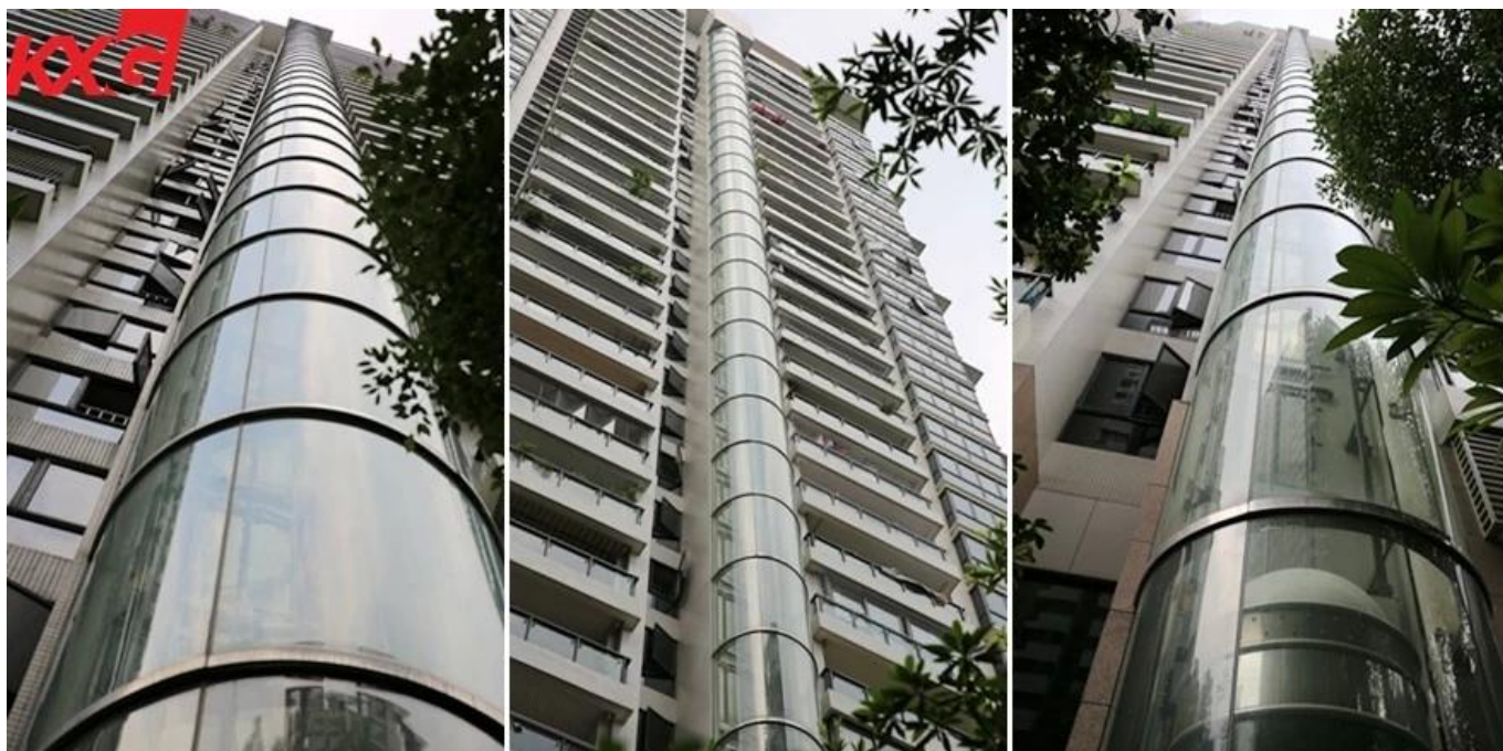
KXG Vidrio de seguridad laminado curvo 8 + 8 mm equipo
